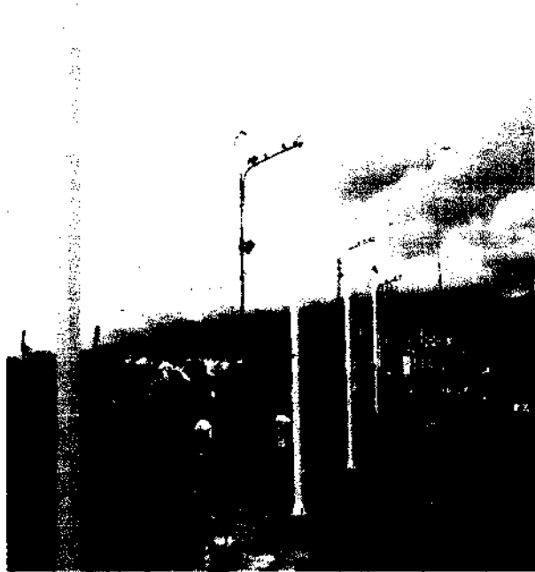
COLOCACION DE COLUMNAS METALICAS SE MANTUVO COMUNICACIÓN DIRECTA CON LOS USUARIOS PARA EVITAR INCIDENTES
