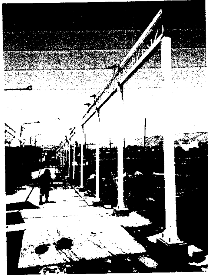
Vigas perimetrales fijadas a columna metalica.
